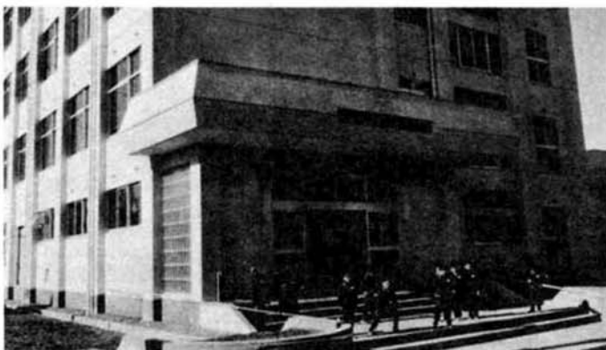
着々と進む教育施設の整備
