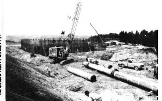
上水道第七期拡張事業(上層配水池)
