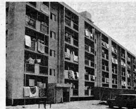
■ 市営住宅(希望が丘団地) 昭和50年3月25日完成 鉄筋コンクリート造5階建 総事業費 1億9,045万円
