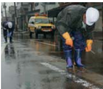
消雪パイプの点検作業
