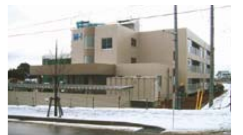
完成間近の上除市営住宅
