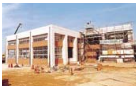
建設が進む余熱利用施設(寿3)
