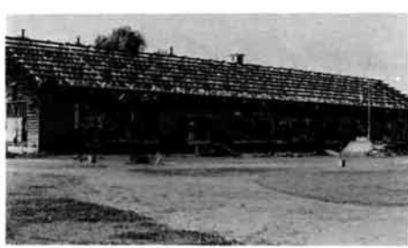
50年の役目を終え解体される脇小体育館
