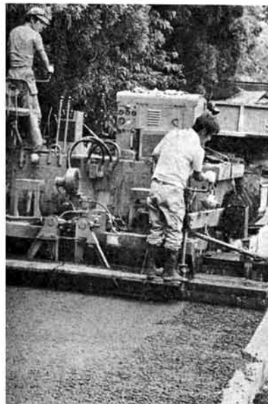
着々と進む道路整備
