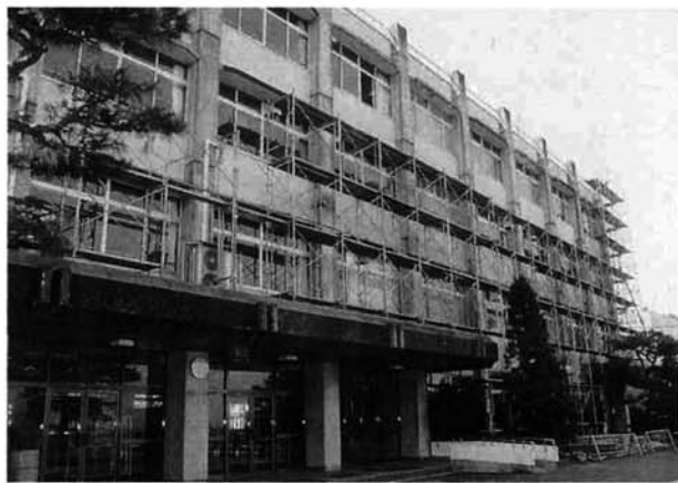
▲ 三島中学校大規模改修
