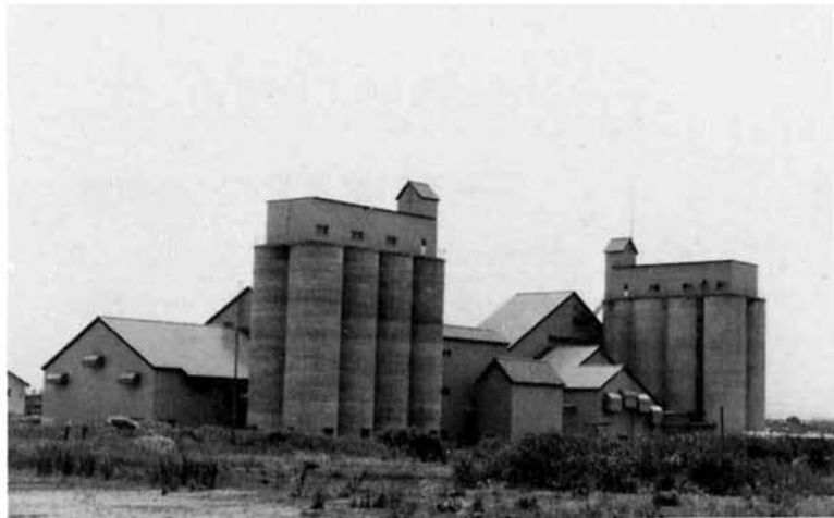
▲ 4,500トン規模のカントリーエレベーター
