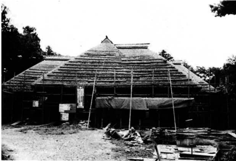
▲ 主屋背面 (東側) 下から茅をふき上がり、棟からハサミで化粧なおしをする。
