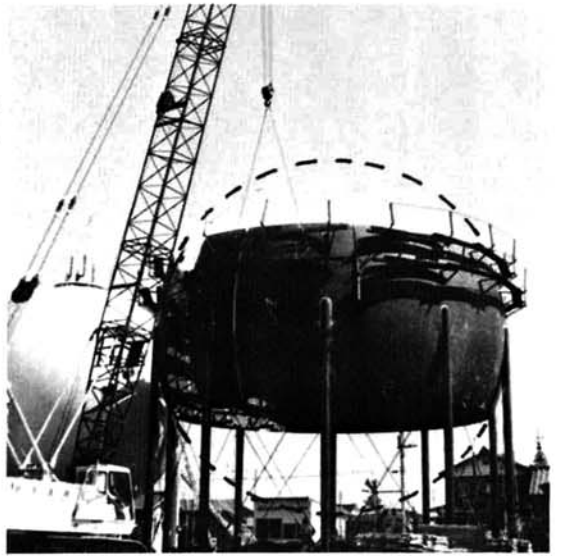
▲高さ17m、直径15.6mの球形ガスホルダーの完成間近(7.23)
