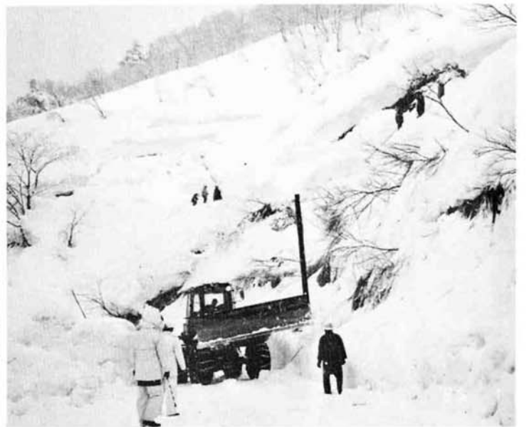
▲町道の雪び落し(1月13日 菅沼地内)
