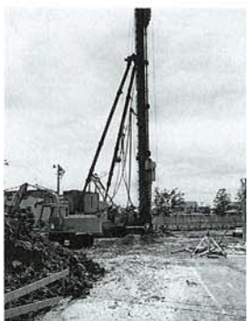
基礎杭打はじまる
