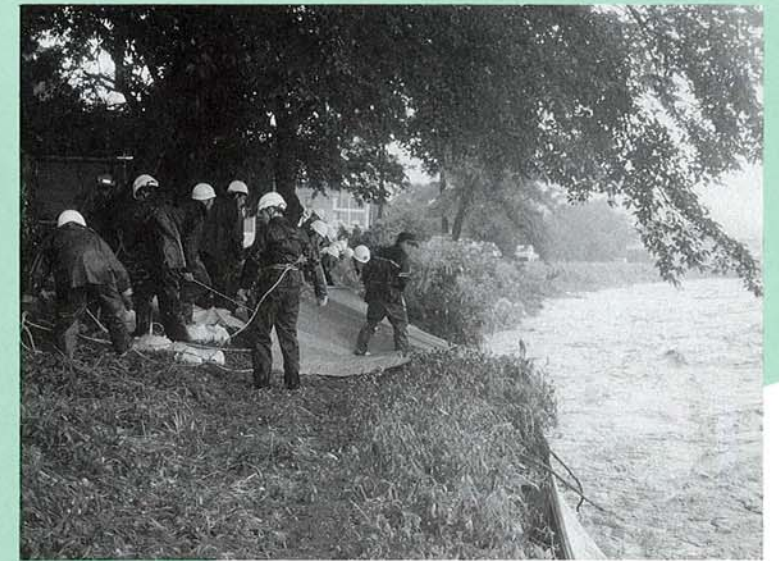
岩塚小学校裏手 堤防決壊防止作業
