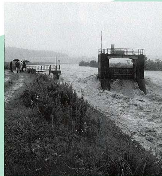
飯塚地内 えん堤付近
