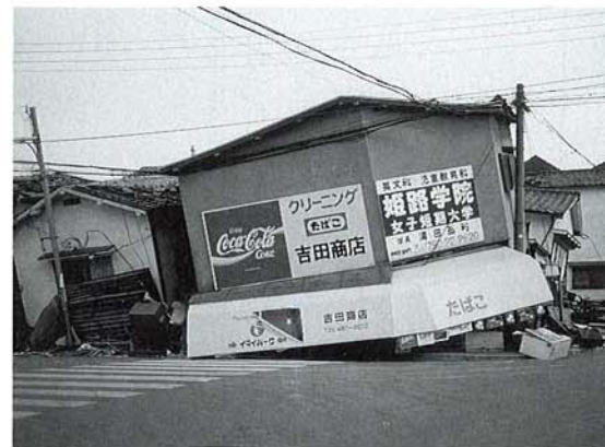
倒壊する建物 神戸市東灘区にて角田先生撮影
