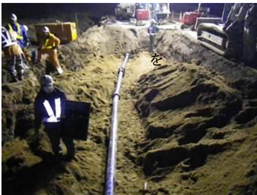
昼夜問わず進められる補修工事
