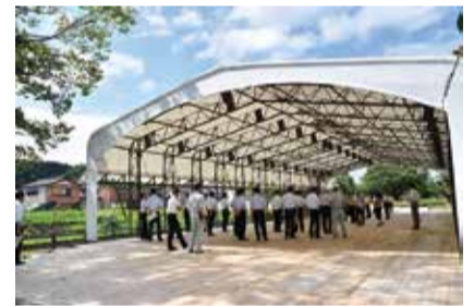
工事中の与板ビール園（7月30日オープン）
