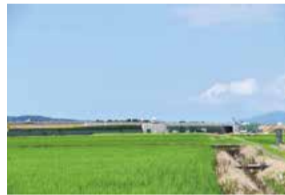
工事中の長岡北スマートIC（平成28年度完成予定）
