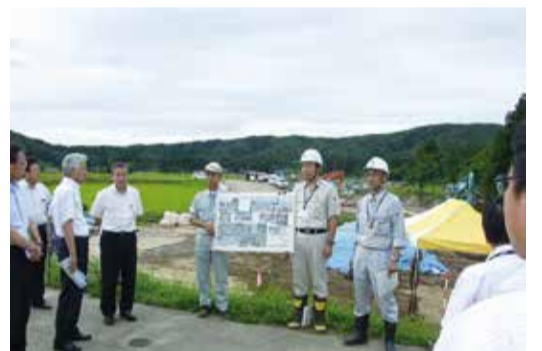
塩谷川災害復旧工事の状況について説明を聞く委員
