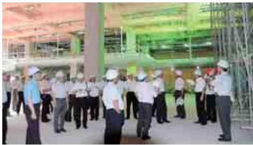
▲アオーレ長岡建設現場
