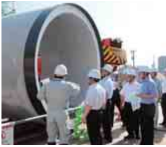
▲浸水対策下水道（貯留管）工事
