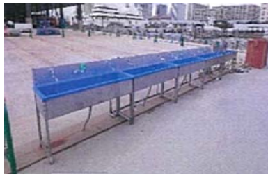
現場の手洗い場所の増設
