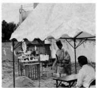
子備貯溜槽の起工式 六月十三日
