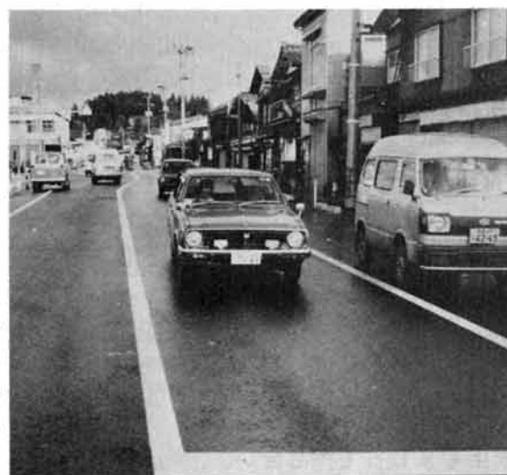
6.5mから13mへ拡張整備した市道栃尾・塩谷線（中央公園前）
