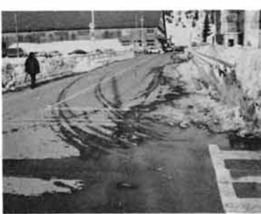
車・歩道の分離ポールを撤収、同時除雪を可能にした旭橋
