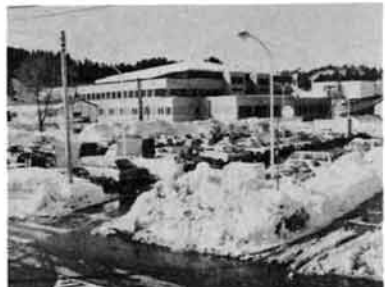
早朝除雪して解放している市営駐車場
