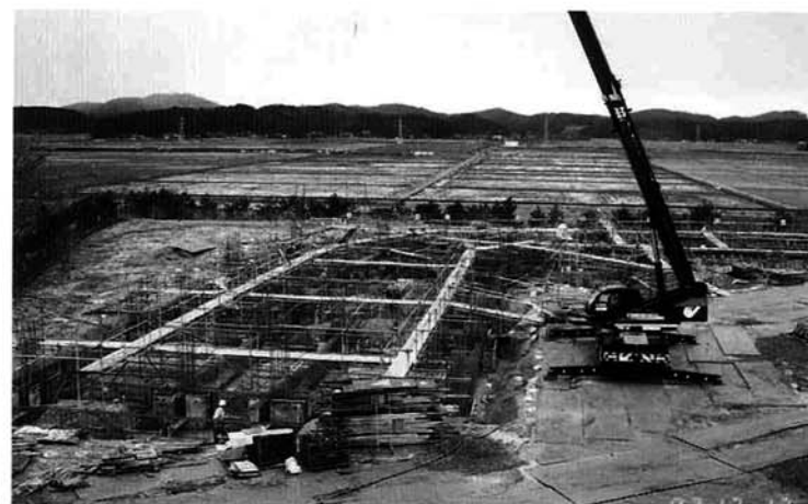
▲着々と進む工事
