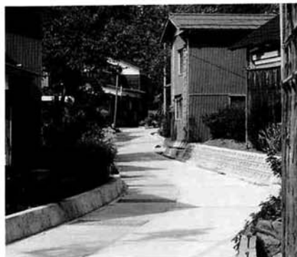
▲ 道路改良工事
