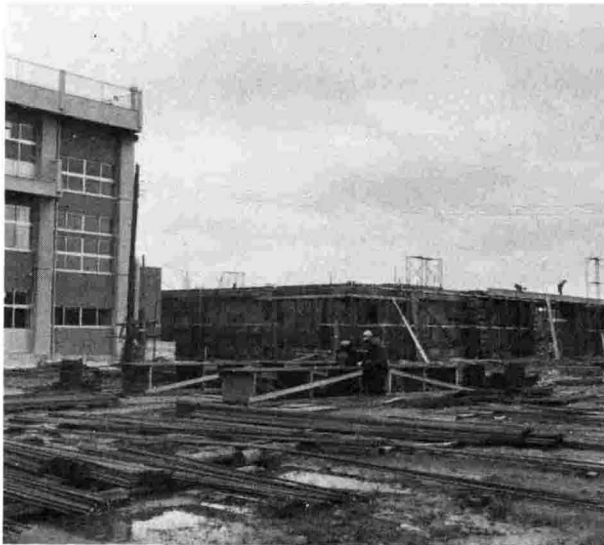
来春完工めざして急ピッチの中央小体育館建設工事
