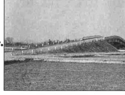
●農業基盤整備事業（広域農道）
