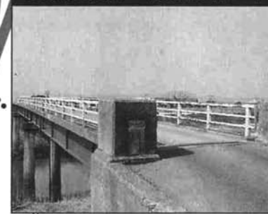
●猫興野橋の維持修繕工事
