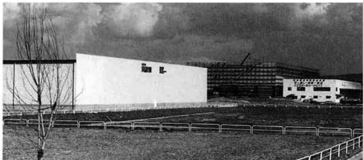
企業の建設が進む流通団地
