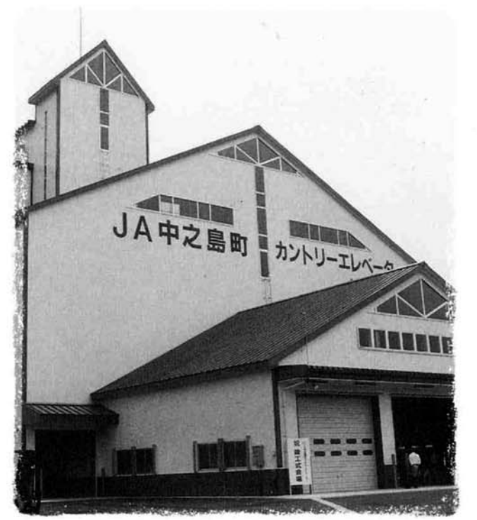
処理量 3000トンのJA中之島町カントリーエレベーター
