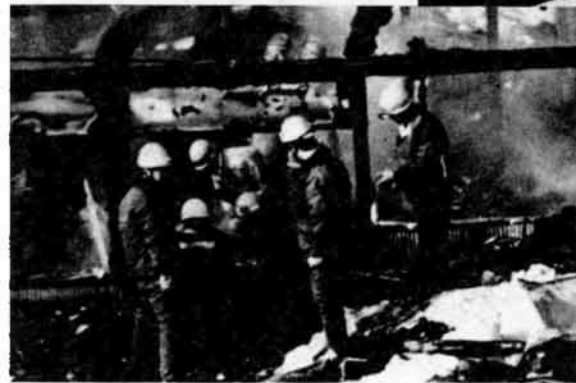
火災原因や損害状況の究明▶は予防対策の貴重な資料に。調査班を組織しての現場検証も大切な業務。
