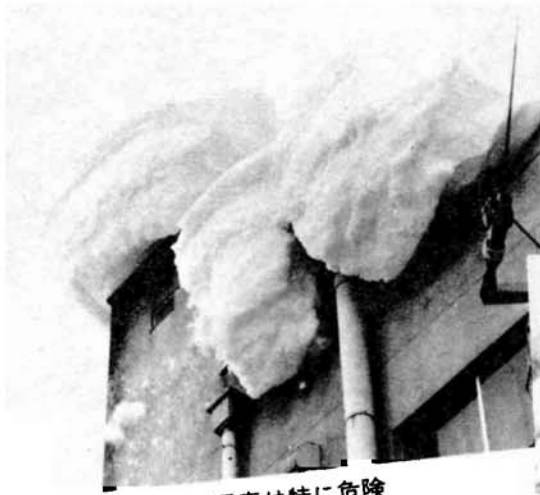
高いビルの雪庇は特に危険
