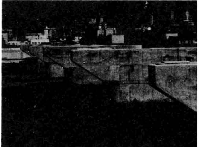
▲今月から新たに橋脚(3基)の建設が再開される大手大橋
