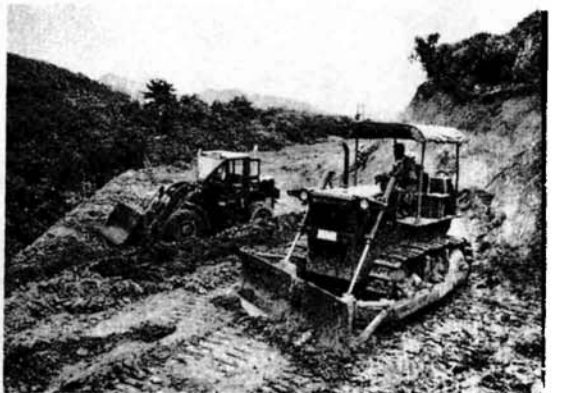
八方台休憩センターまであと500メートル 林道東山線、昨年の工事風景
