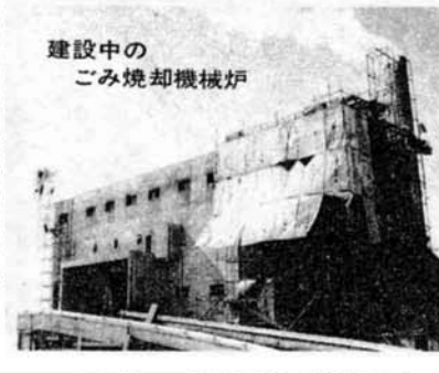
建設中のごみ焼却機械炉
