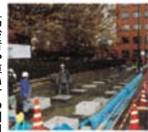
庁舎前南側歩道の雁木の設置工事（11月19日）
