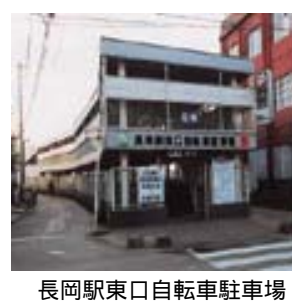
長岡駅東口自転車駐車場
