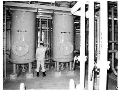
●浸出水処理施設 埋め立てられたごみから出た水を、最新の水処理方式により、河川の水と同じにして、放流します。
