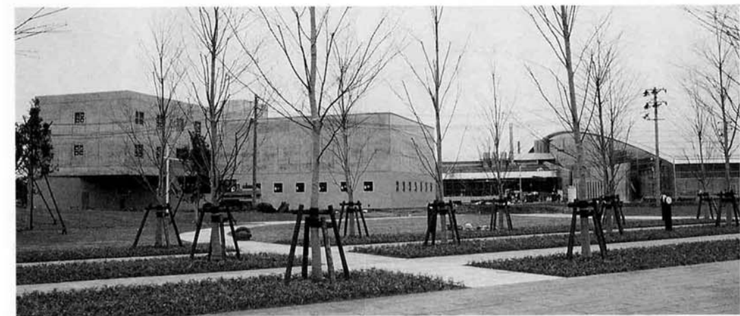
◀急ピッチで工事が進む長岡造形大学キャンパス。かつら並木も形になってきました
